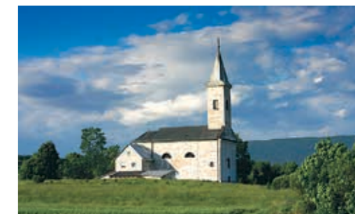
Kościół Wniebowzięcia Najświętszej Marii Panny zbudowany około 1700 roku.
